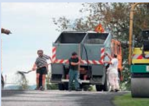
Travaux de point à temps - Mars 2007
